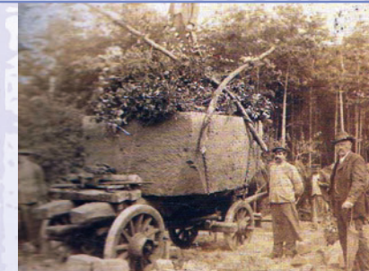
Der Transport der großen Steinquader den Berg hinab war sehr gefährlich: »Sicherung« mit querspannten Ästen
